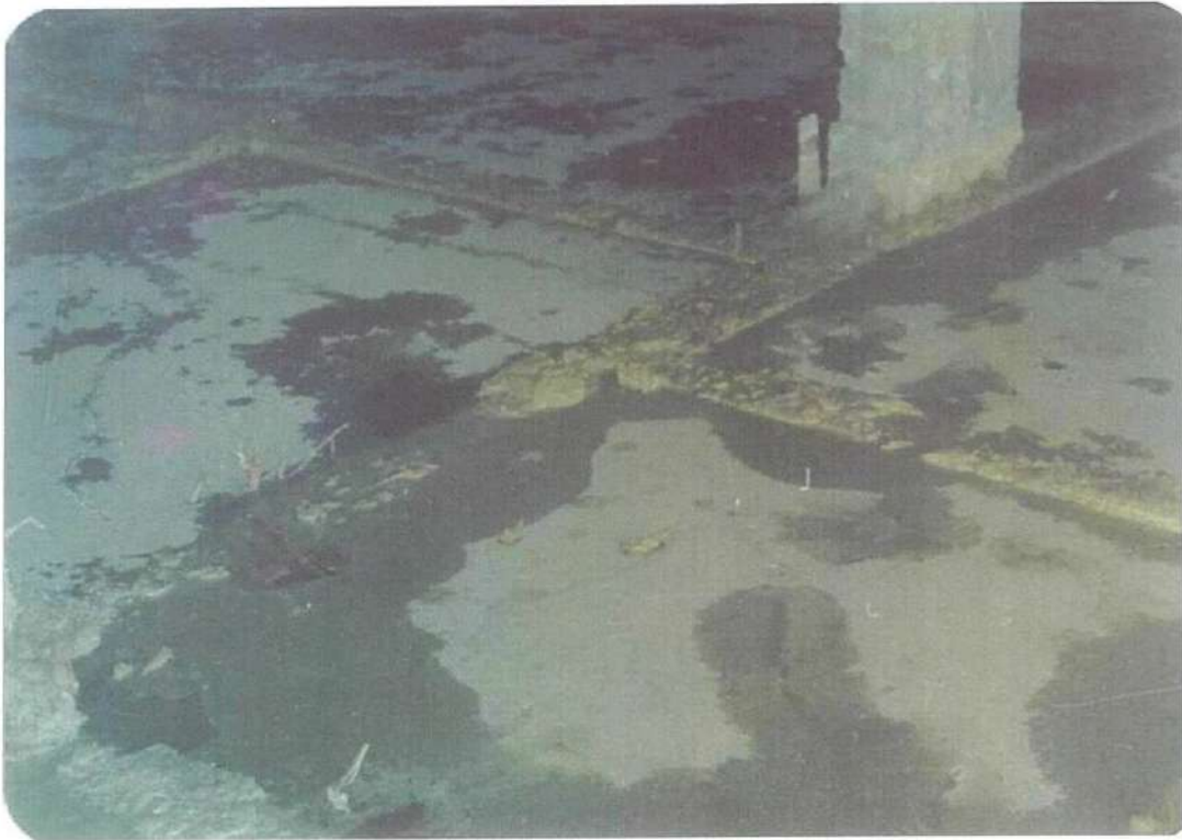
أشكال (٤١-٢) (٤٢-٢) تمليح بخرسانة الأعمدة وتآكل خرسانة الميدات وعدم العزل
