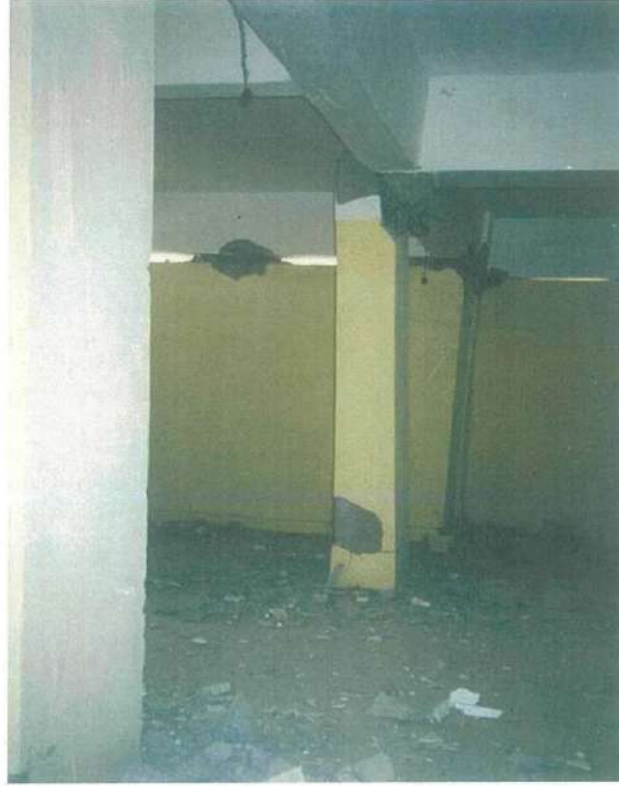
صورة رقم (٣-٣٩) توضح كسر بالأعمدة وميول واضحة بها عند اتصالها بالكمرات
