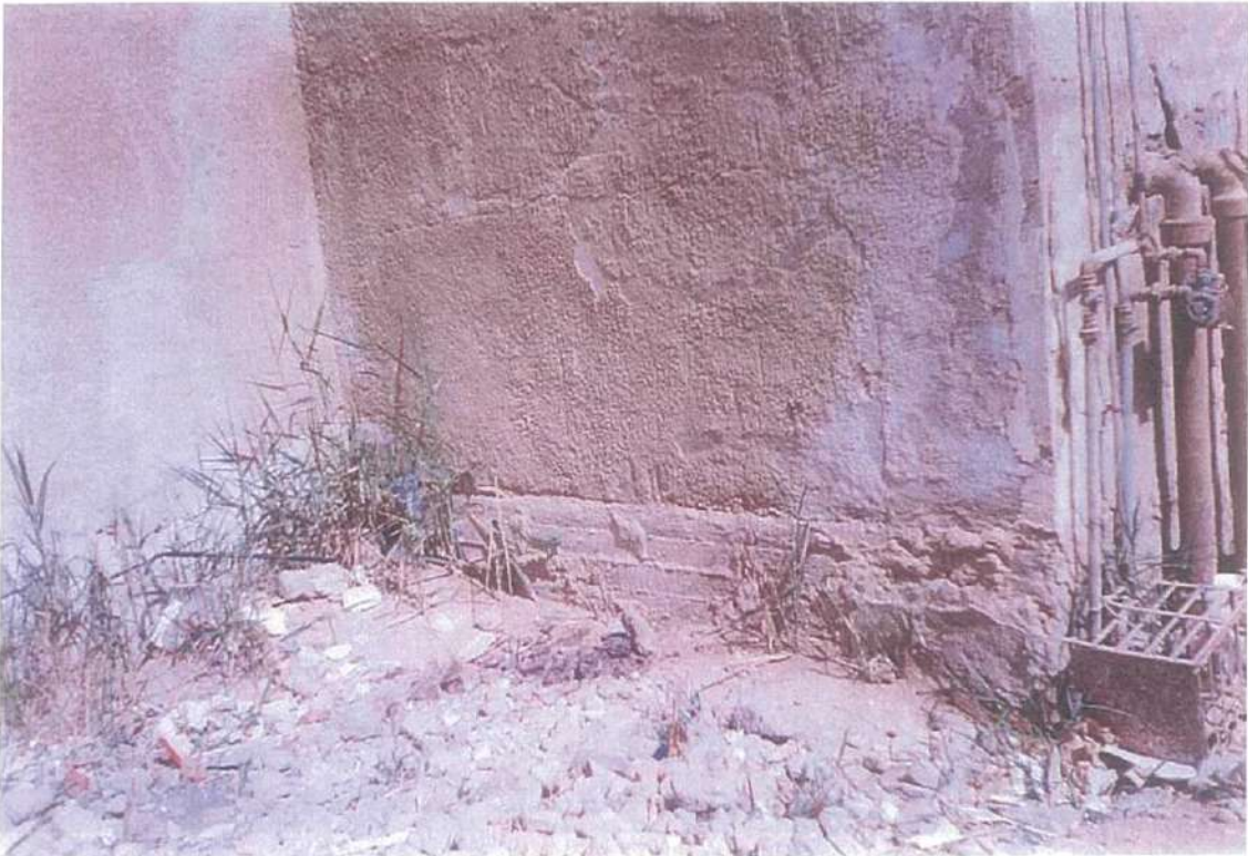
صورة رقم (٦٤-٣) توضح سوء حالة السباكة والتوصيلات الصحية الخاصة بالعمارات
