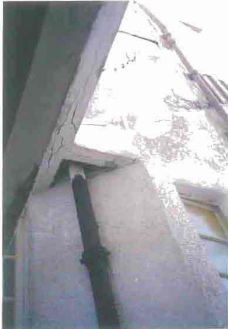
صورة رقم (٣-٣٠) توضح شروخ في الحوائط والكمرات كنتيجة لسوء حالة الصرف الصحي
