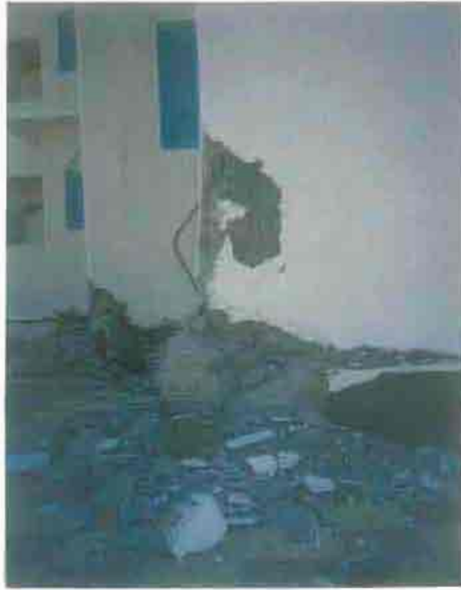
صورة رقم (٤١-٣) توضح كسر بالعمود وتلاشي العمود بمنطقة الشباك
