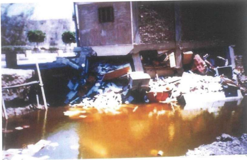
صورة رقم (٥١-٣) توضح أنطباق سقف الدور الأول وسقف الدور الثانى على أرضية الدور الأول
