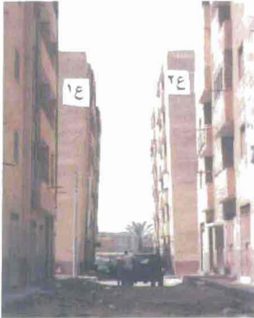
صورة رقم (٣-٢) : توضح ميل عمارتين بسبب عيوب في تربة التأسيس [٦]
