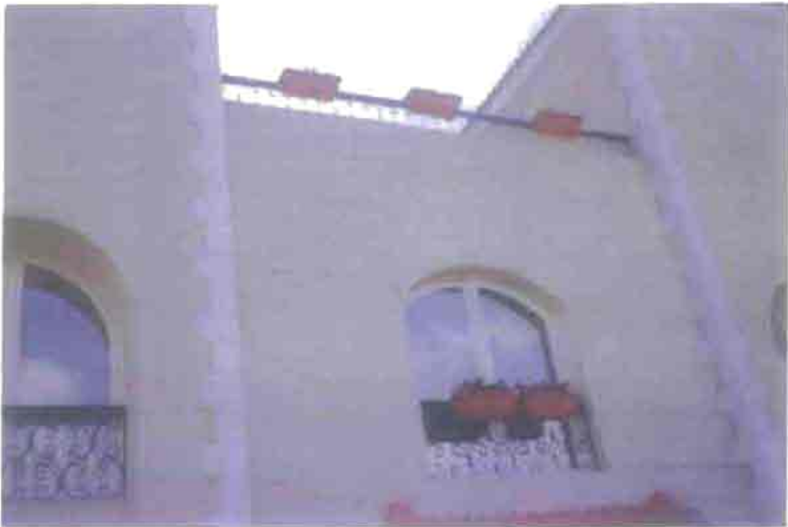
صورة رقم ( ٦٨-٣ ) شرح مائل بحائط بملكوثة بالدور الأرضي
