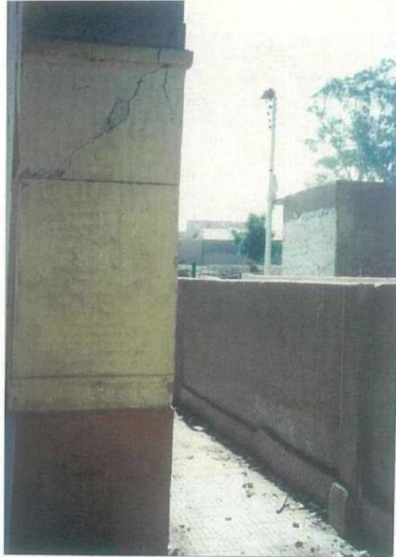
أشكال (٤٣-٢) (٤٤-٢) كسر بأعمدة الركن دحَاب العمارات بالدور الأرضي نتيجة لحدوث زلزال .
