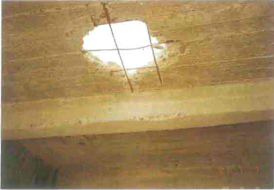
شكل (٢-٢٣) سوء تنفيذ بلاطة السقف الخرسانية
