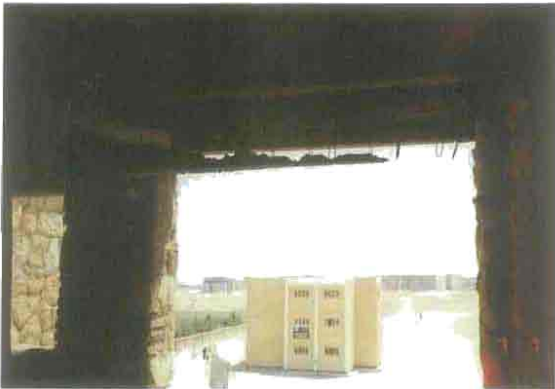
شكل (٢-٢٤) سوء تنفيذ العتب فوق فتحة الشباك .
