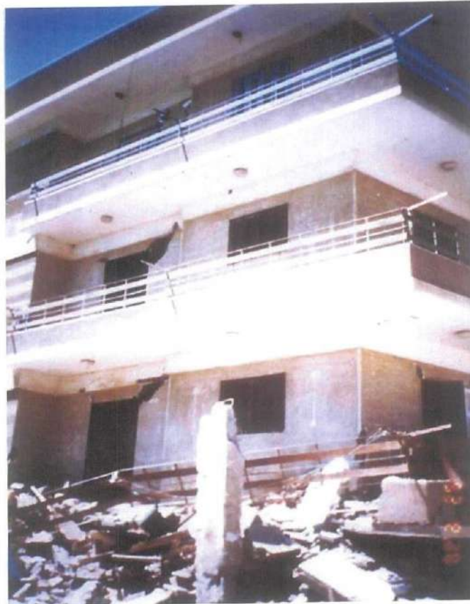
صورة رقم (٥٢-٣) توضح الإزاحة الأفقية للجزء المتبقى من العمارة ناحية الحفر
