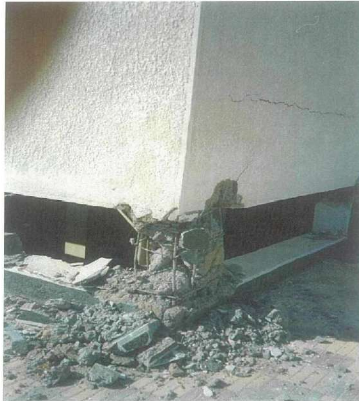
صورة رقم (٤٦-٣) توضح كسر بخرسانة الاعمدة بالبديوم
