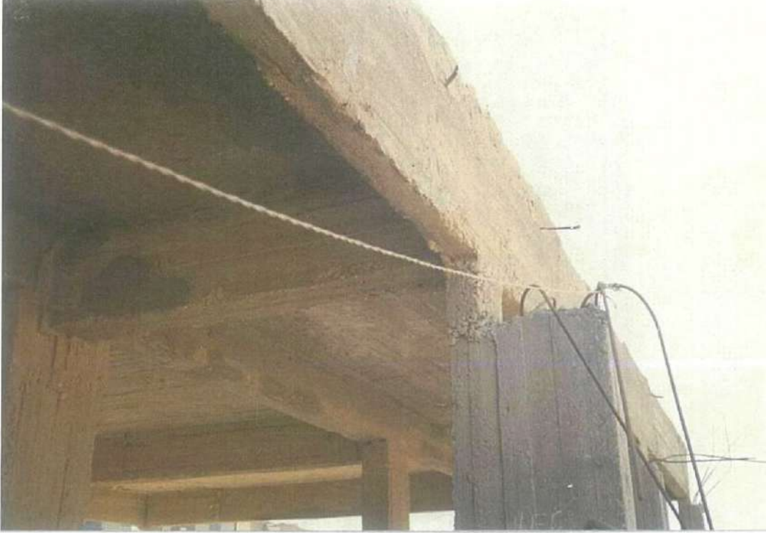
شكل (١١-٢) سوء التنفيذ يظهر في عدم صب قطاع العمود كامل حيث تم إنشاء جزء فقط من الدور الأخير لذلك فإن هذا الوضع سوف يتسبب في حدوث لا مركزية للتحميل على العمود.
