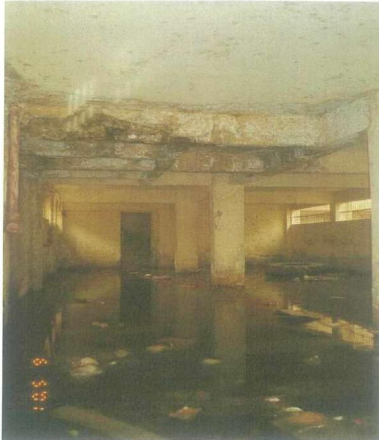
صورة رقم (٣-٦٠) توضح سوء حالة أعمدة الصرف الخارجية والعناصر الإنشائية المحيطة به
