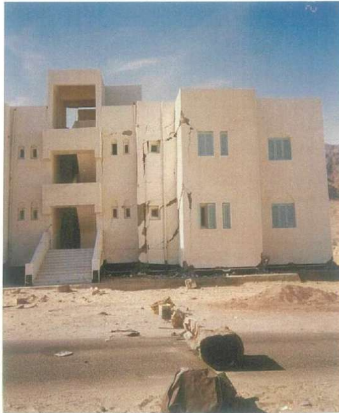
صورة رقم (٣-١٩) شروخ مائلة بالواجهة الرئيسية نتيجة لفروق الهبوط بين الاساسات
