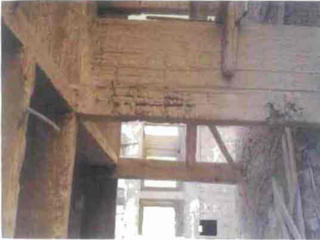
شكل (٨-٢) تعشير في خرسانة العمود وظهور بقايا الأخشاب الخاصة بالفرم ملتصقة بالخرسانة
