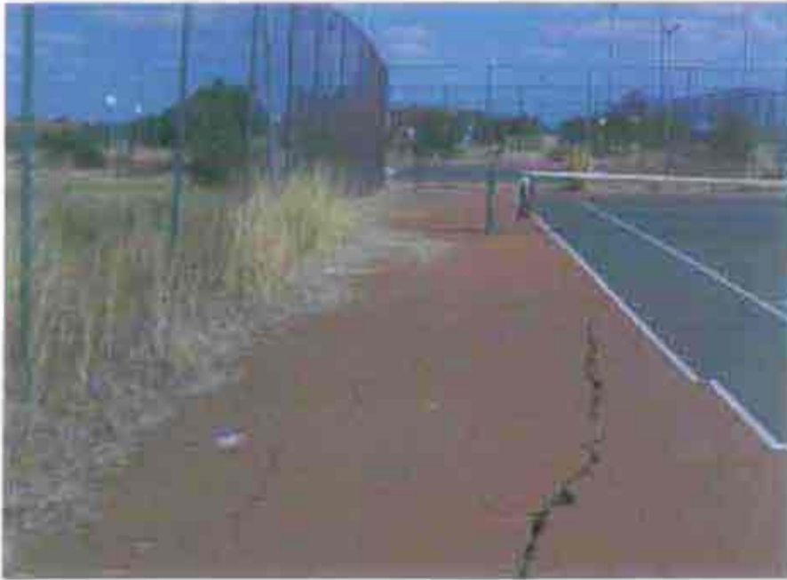
صورة رقم ( ٣-١٢ ) : توضح شروخ متنوعة بالطرق بسبب ثرية للتفاحية |٣٨|
