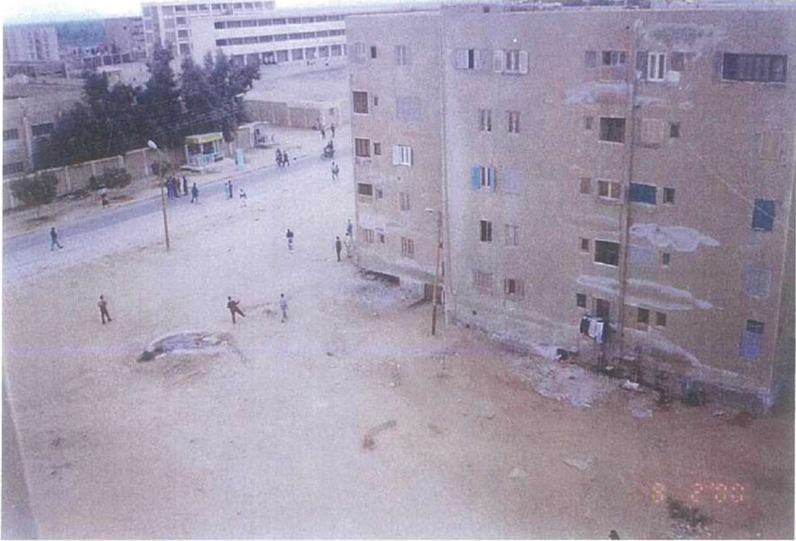
صورة رقم (٣-٥٩) توضح سوء حالة عمليات عزل الحمامات ورشح ورطوبة وتمليح على الواجهة للعمارتين
