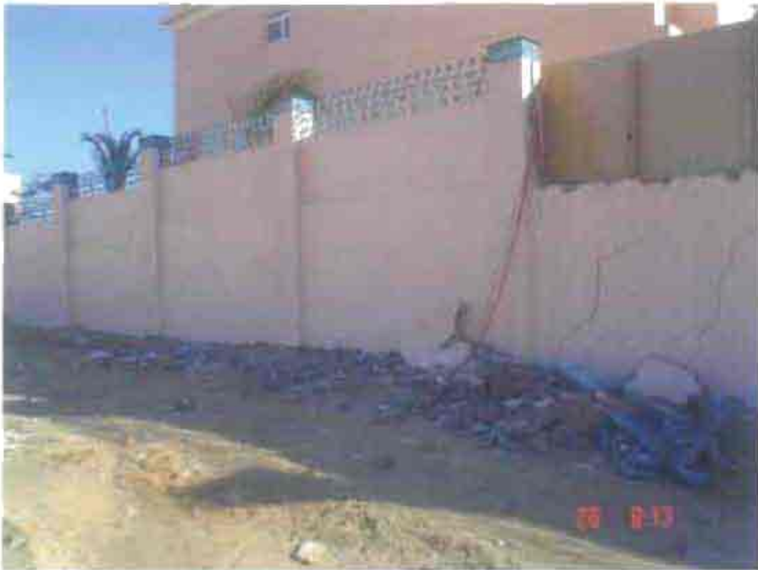
صورة رقم (٧٤-٣) لتهدم السور الخارجي للفيلا
