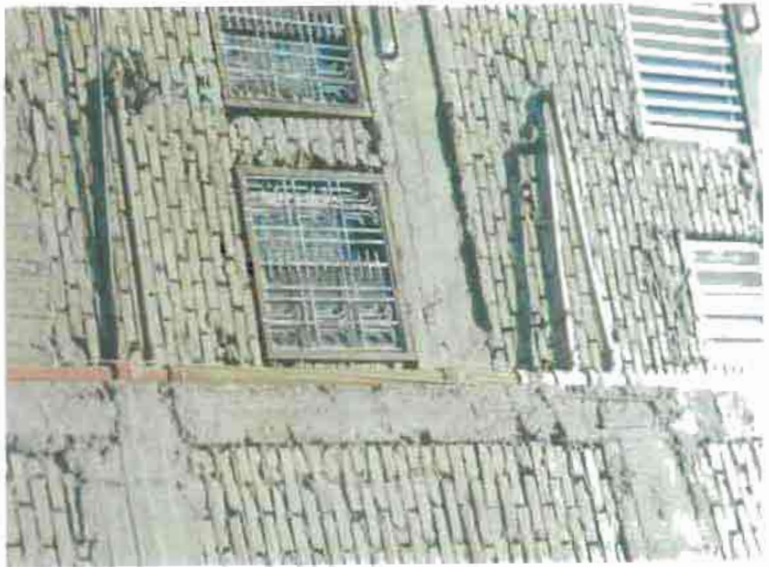
الشكل (١٥-٢) (١٦-٢) سوء تنفيذ خرسانة الأعمدة وحدوث تشقق بها وكذلك عدم راسية الأعمدة
