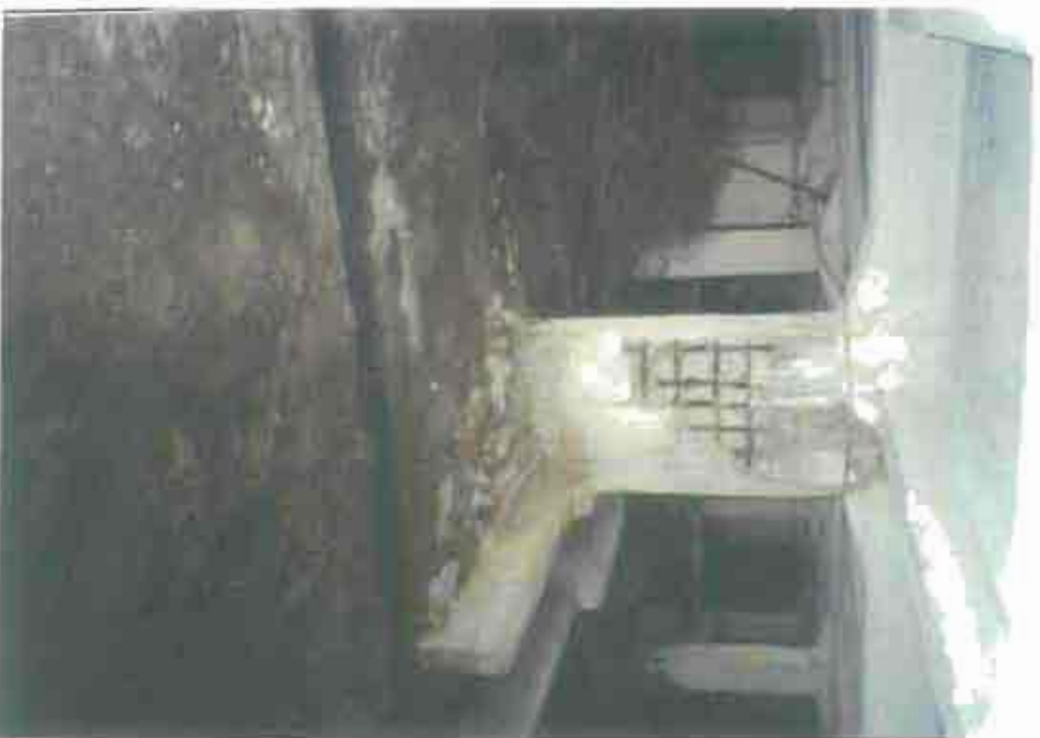
شكل (٢-٢٠) صمأ شديد يحدث بسبب تساقط أجزاء قسما لا الحاملة وتجميع المخلفات على التربة وتتبع التربة بالمواد الكيميائية حيث لا يوجد نظام حاصر لصرلها مما يسبب تساقط الأجزاء والعماسات والعماسات الإسفلتية الحاملة للملبي في تآكل الأساسات
