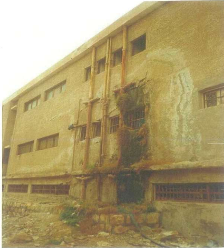
صورة رقم (٥٥-٣) توضح سوء حالة اعمدة الصرف الخارجية والعناصر الإنشائية المحيطة بها
