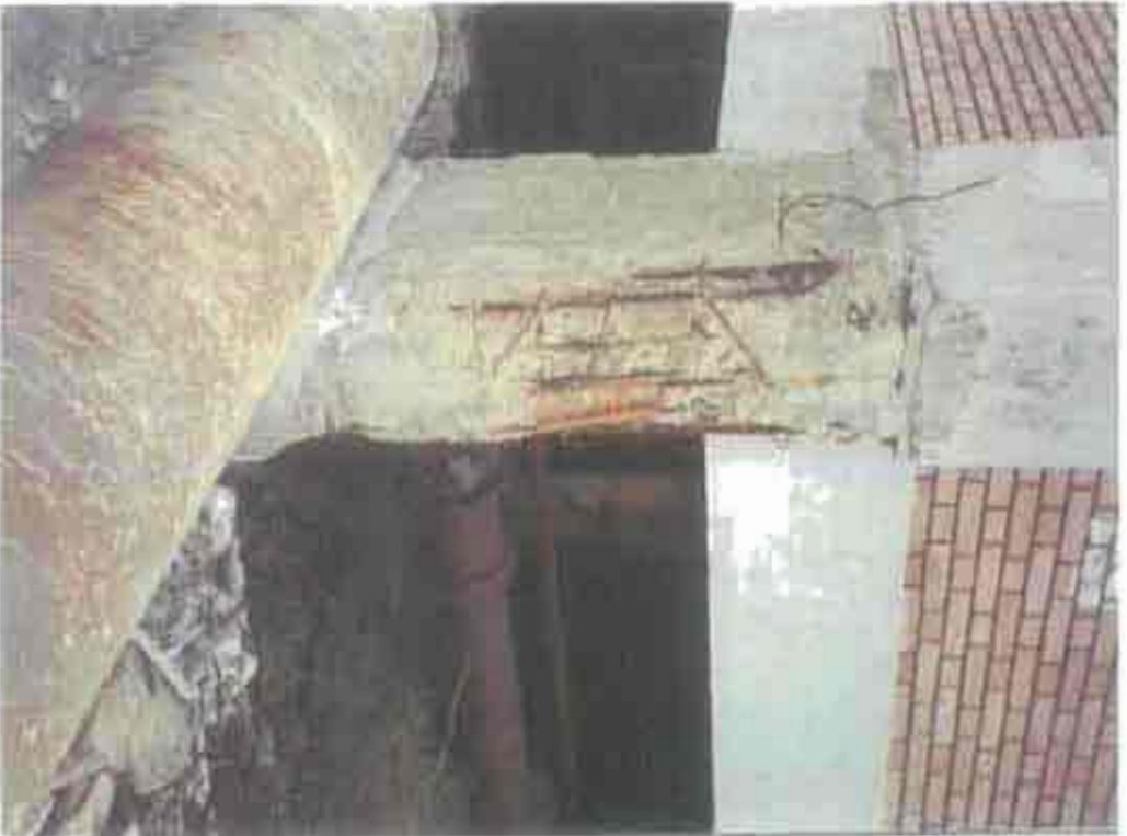
شكل (٢-١٩) تآكل بخرمسالة الإصمدة وصمأ بحدود تسليحها نتيجة إستخدام مواد غير مطابقة للمواصفات وسوء التنفيذ
