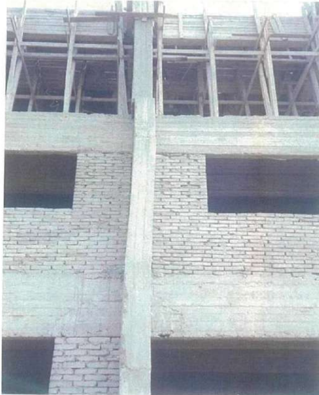
شكل (١٢-٢) عدم رأسية العمود الخرساني وعدم انتظام مقطعه.
