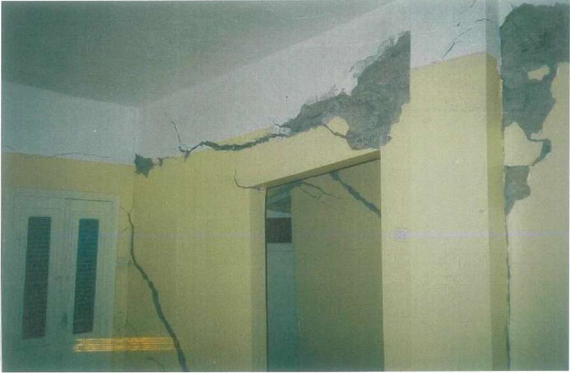
صورة رقم (٣-١٨) توضح شروخ مائلة بالحوائط نتيجة لفروق الهبوط بين الاساسات
