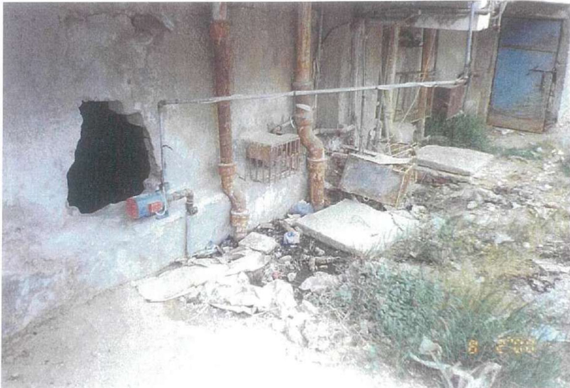
صورة رقم (٦١-٣) توضح تراكم مياه الصرف الصحي في بدروم العمارة
