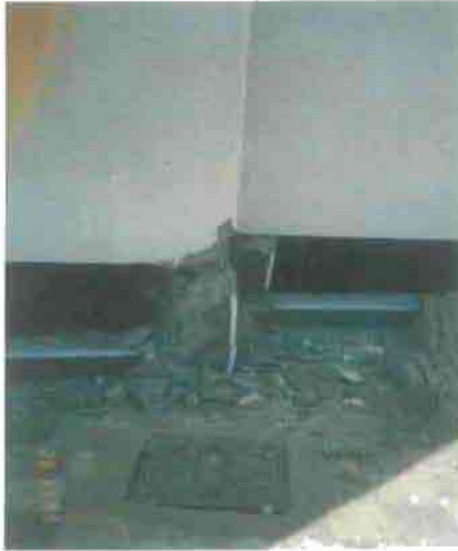
صورة رقم (٤٣-٣) توضح كسر بخرسانة أحد الأعمدة بالبروم
