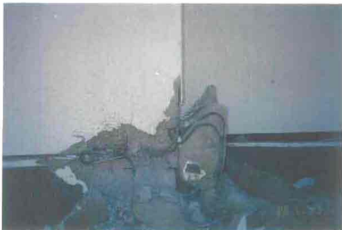
صورة رقم (٤٧-٣) توضح كسر بأحد الأعمدة والتمليح بالأعمدة باليدروم
