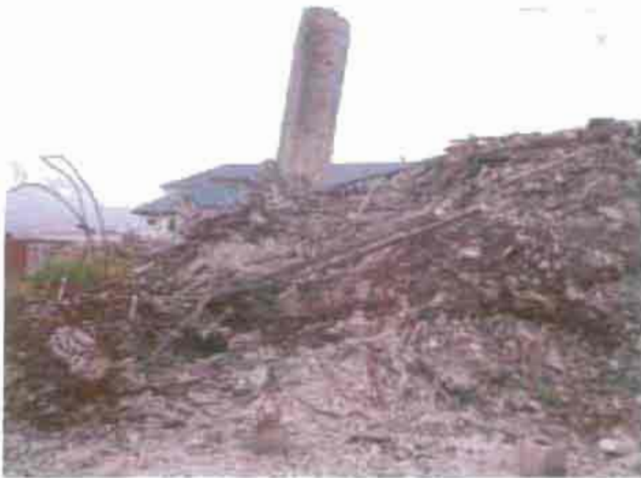
صورة رقم ( ٣-١٣ ) : توضح بقايا انهيار مبنى من خمسة طوابق في نيجيريا |٤٩|
