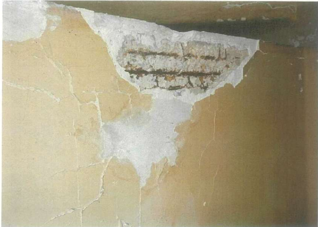
شكل (٢-٢٨) تآكل كلي لأسياخ الحديد نتيجة للصدأ الشديد لحديد البلاطة الخرسانية وذلك بعد ازالة التطبيل الموجود بها مع ظهور شروخ مطابقة لحديد التسليح في باقى البلاطة
