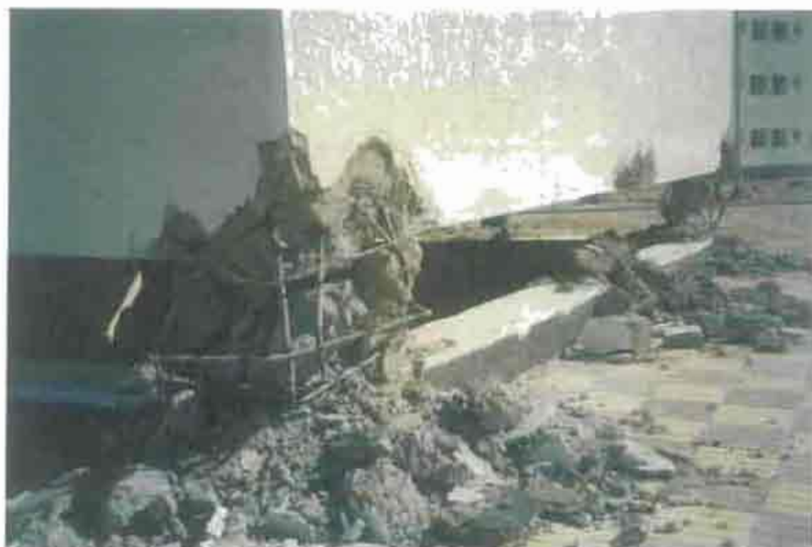
صورة رقم (٤٧-٣) توضح كسر بأحد الأعمدة والتمليح بالأعمدة باليدروم
