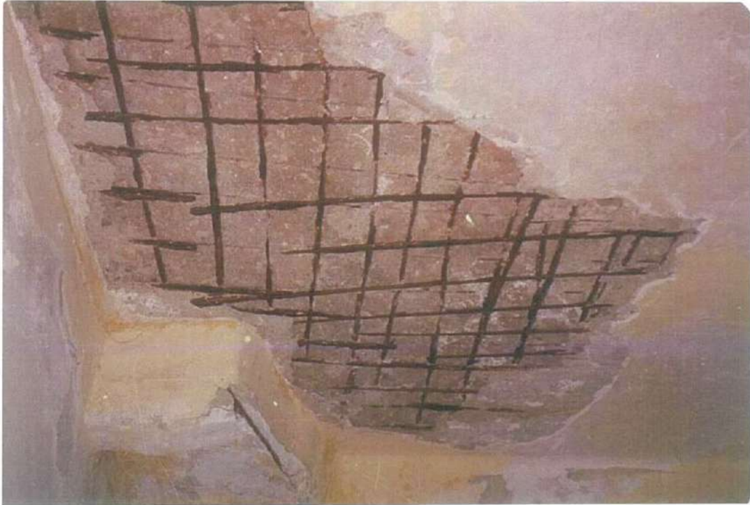
شكل (٢-٢٧) سقوط الغطاء الخرساني وظهور أسياخ حديد التسليح وبها صدأ شديد مع ملاحظة تآكل بعض الأسياخ كلياً
