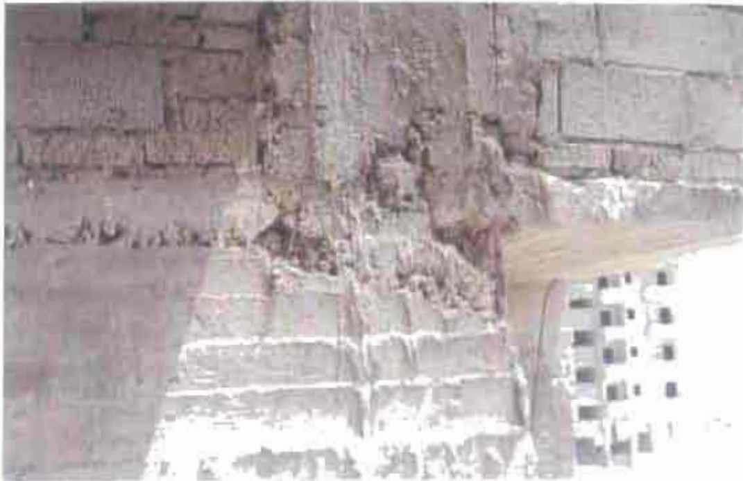
أشكال (٢-٩) (٢-١٠) تعشيش شديد في الخرسانة وظهور حديد تسليح العمود بدون غطاء خرصاني مع سوء تنفيذ الوصلة بين الكمره والعمود.
