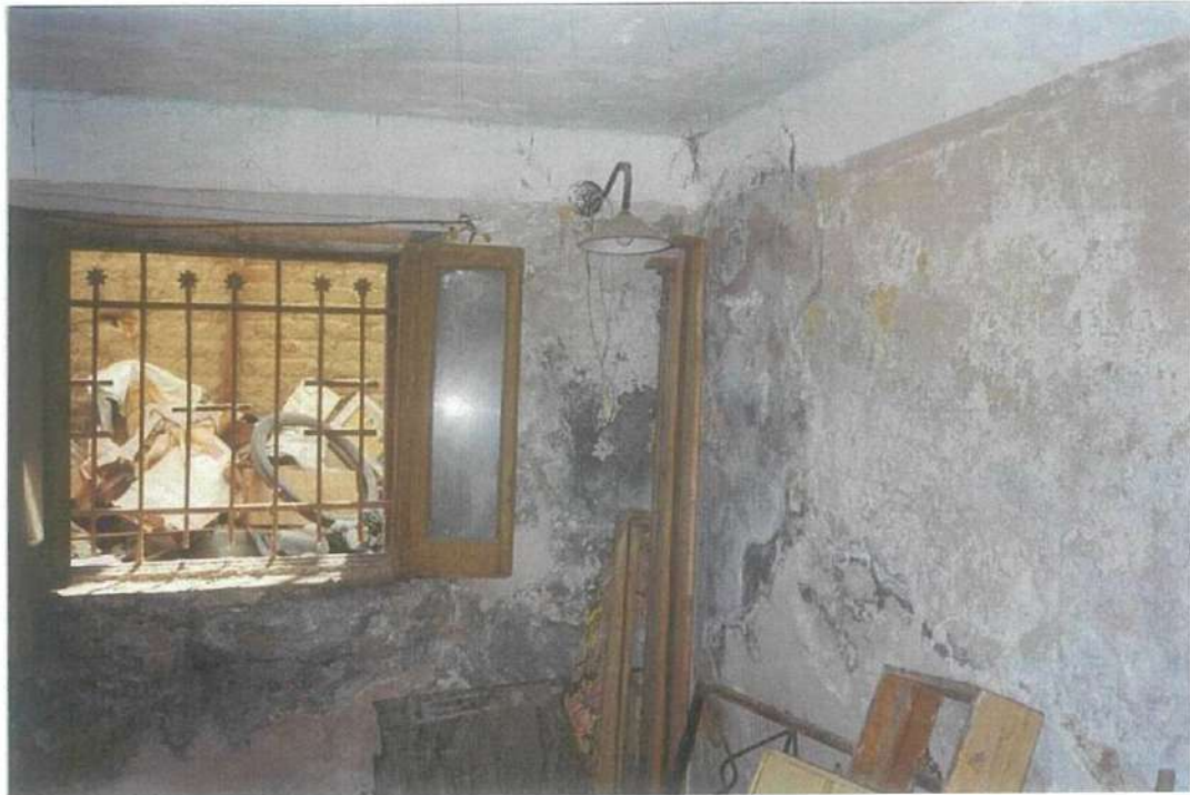
شكل (٣٨-٢) نشع المياه في بדרوم أحد العقارات وظهور الرطوبة على الحوائط وتأكلها
