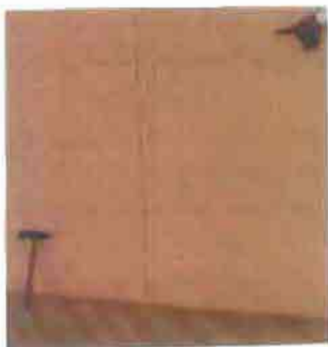
صورة رقم ( ٤-٣ ) . توضح شقوق مائلة تم ترميمها وشقوق للأسفلت بسبب التربة [١٠]
