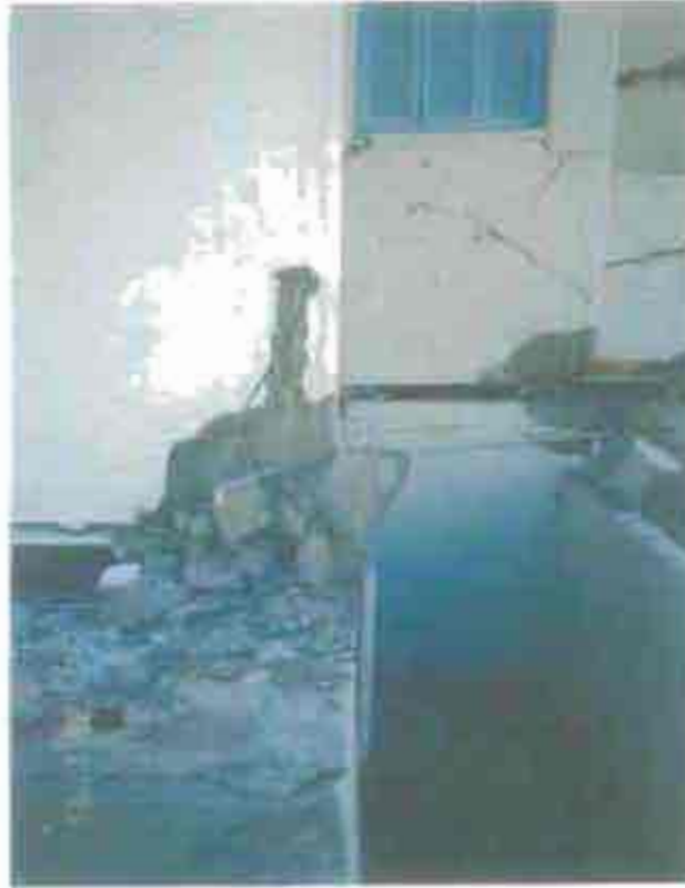
صورة رقم (٤٩-٣) توضح كسر بالعمود وثلاثى العمود بمنطقة الشبابيك
