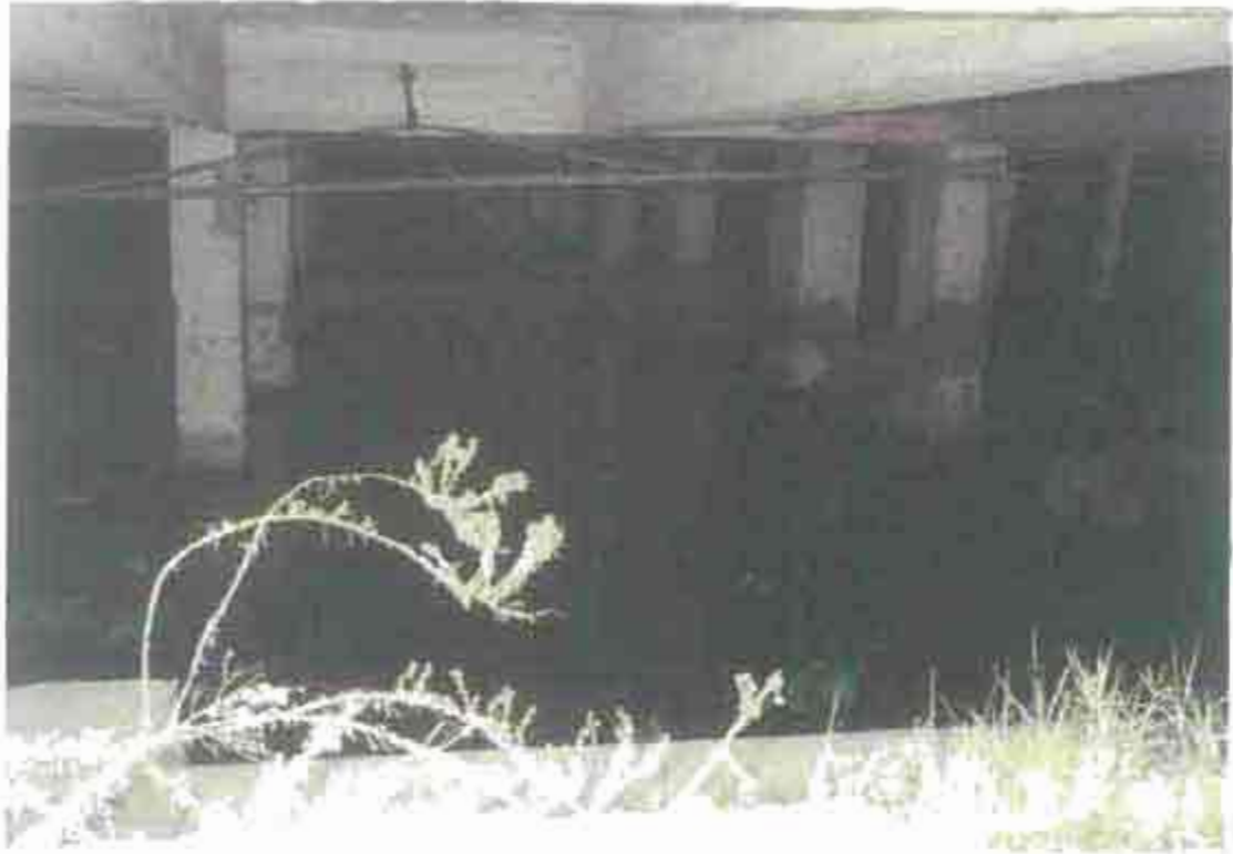
شكل (٢-٢١) تسرب المواد الكيماوية على الأعمدة الخرسانية وتشبع التربة بها مما يتسبب في تصدع العناصر الخرسانية والأسلوب العشوائي لتثبيت الكابلات الكهربائية
