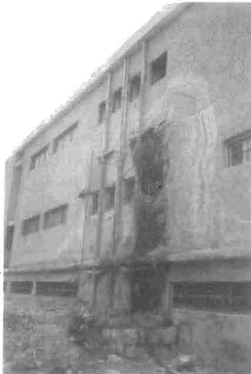
صورة رقم (١-٣) : توضح سوء حالة أعمدة الصرف الخارجية على العناصر الإنشائية المحيطة به |٥|
