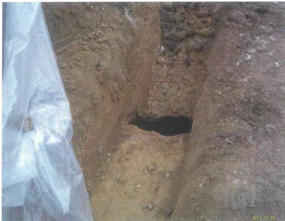
صورة رقم ( ١٠-٣ ) : توضح فجوات في تربة التأسيس التي تتكون من طين متماسك [٣٦]
