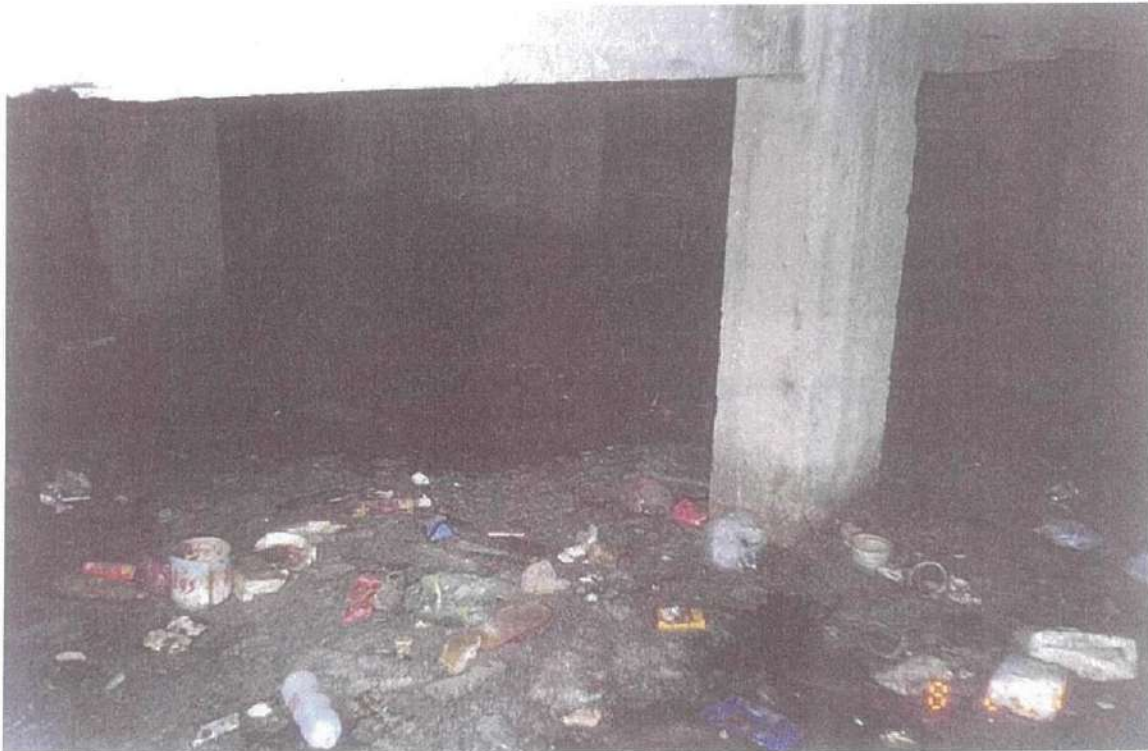
صورة رقم (٥٤-٣) توضح تراكم مياه الصرف الصحي ببدرومات العمارات بسبب سوء حالة الصرف الصحي
