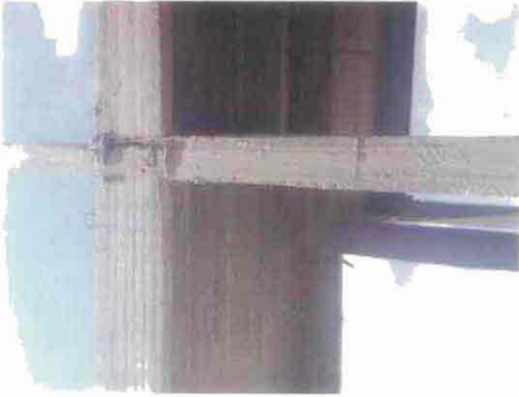
شكل (٧-٢) عدم إنقحام قطاع العمود مع ظهور حديد التسليح بدون عطاء خرسانتي نتيحة تعشير الخرسانة عند رقيبة العمود
