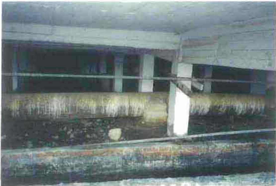
شكل (٢-٢٢) تشبع التربة بمواد الصباغة نتيجة عدم تصميم أسلوب لصرف تلك المواد مما يؤثر على سلامة لعناصر الإنشائية .
